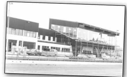
Här en bild från läktarbygget som tillkom och färdigställdes något senare.
